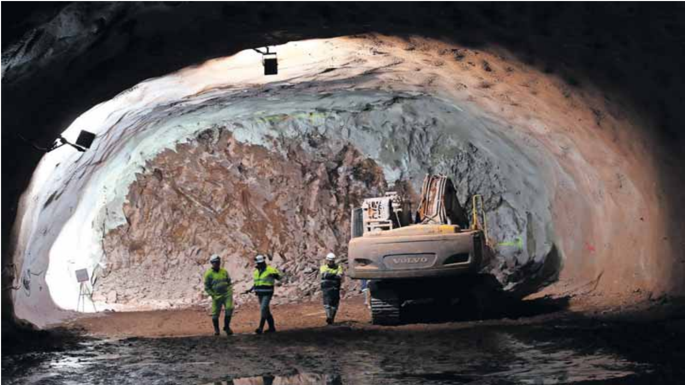
Obras de excavación en la boca norte de los túneles de Belate en febrero de este año.
